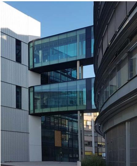
En façade Sud, se trouvent les bureaux et les salles de réunion, protégés du soleil par la maille en aluminium. Les fenêtres, cachées dans le bardage s'ouvrent facilement par un système de volet coulissant.
